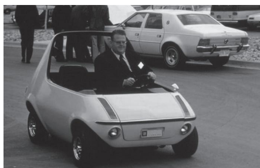
图 1-4 1969 年通用的微型混合动力实验车 512 系列
