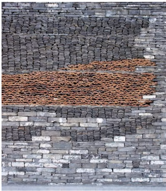
▲ 图 1-4-5 宁波博物馆由旧砖瓦、陶片毛竹和混凝土组成的建筑外墙 / 设计师：王澍
