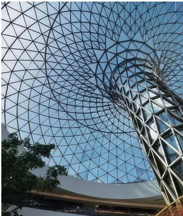
▲ 图 1-4-15 上海某商场中庭
