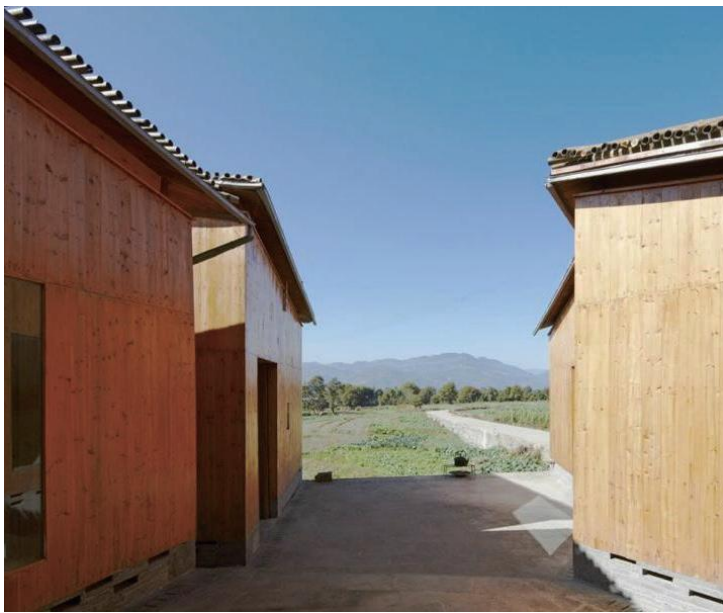
▲ 图 1-4-6 云南高黎贡手工造纸博物馆由杉木、竹子组成的建筑外墙 / 设计师：华黎
