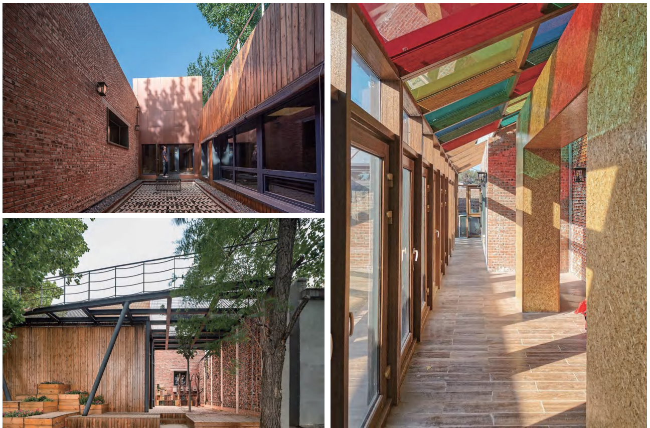
▲ 图 1-4-20 天友·零舍乡居空间改造项目
