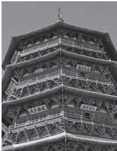
图 1-5 应县木塔的榫卯结构
