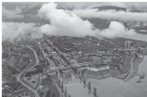
图 1-8 三峡双线五级船闸
