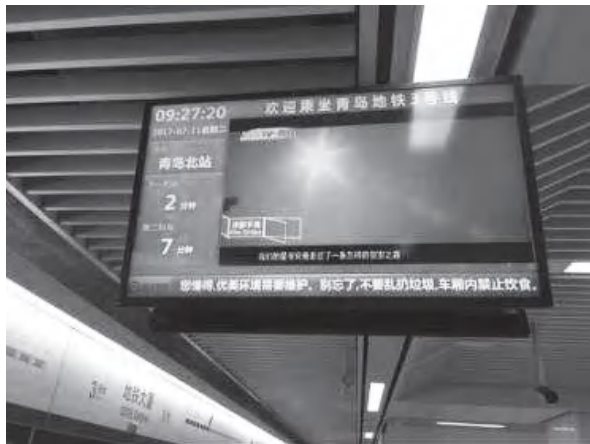
图 1-2-3 站台信息显示终端显示到站信息
