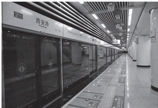
图 1-2-9 干净整洁的地铁站台
