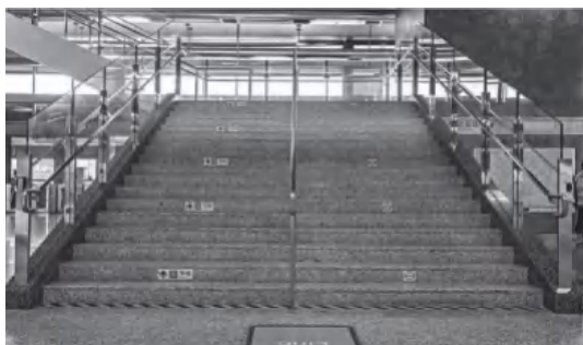
(b) 连接站厅站台处楼梯
