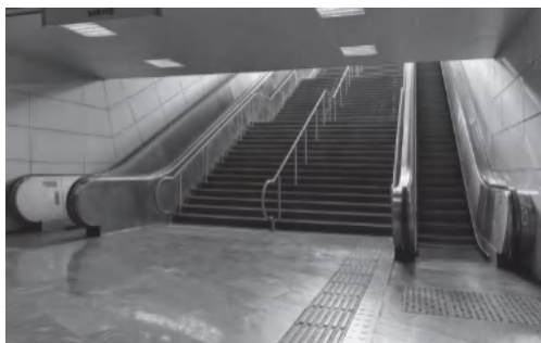
(a) 出入口处楼梯
