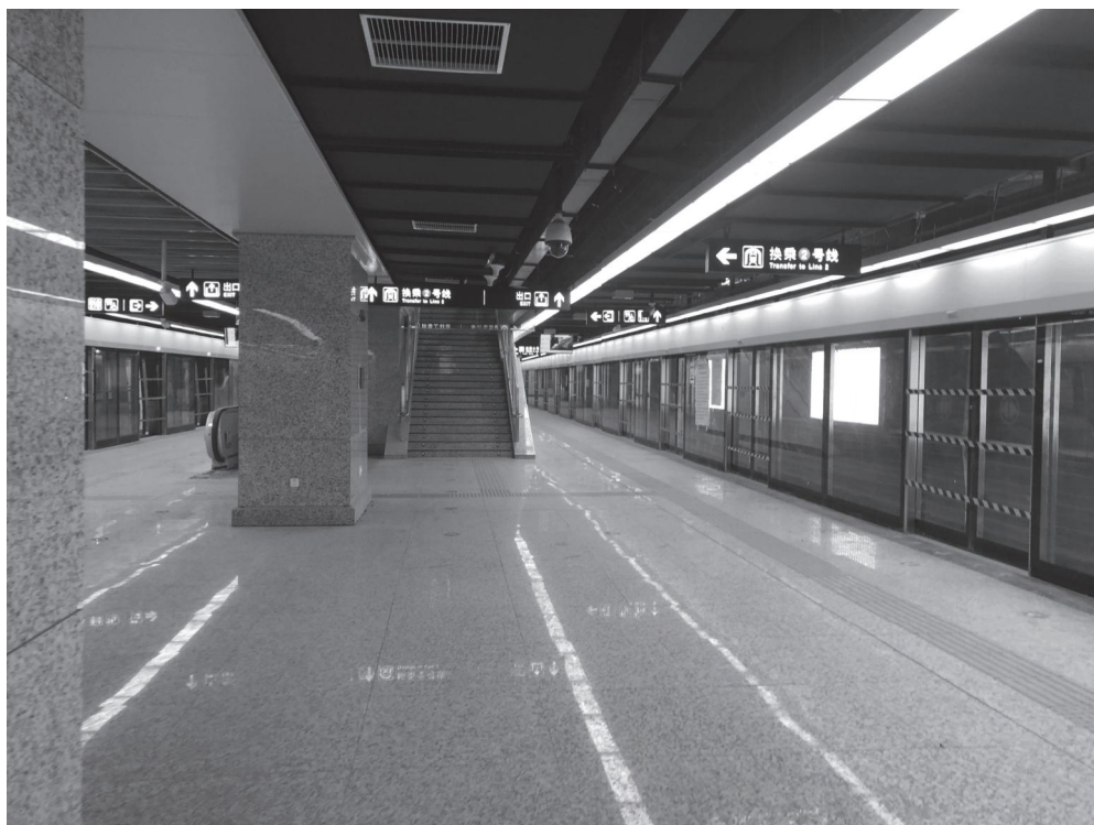
图 2-1-5 岛式站台现场照片
