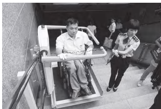
图 1-2-5 站内无障碍电梯设备
