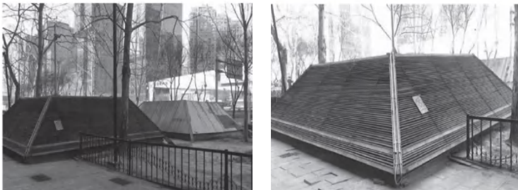
图 2-2-29 北京地铁 1 号线大望路站风亭
