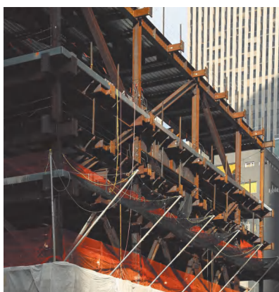
(a) 纽约街头施工中的钢结构建筑框架
