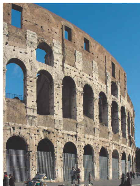
图 1-2-13 原始混凝土在罗马大斗兽场建筑中扮演了不可或缺的角色
