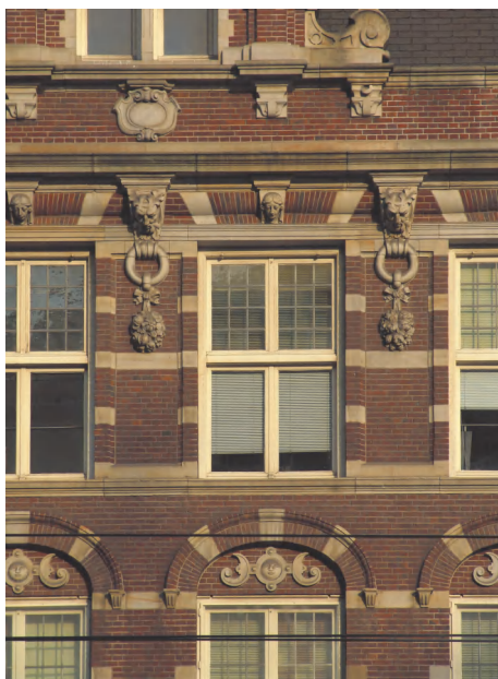
图 1-2-9 荷兰历史建筑中造型丰富的砖墙
