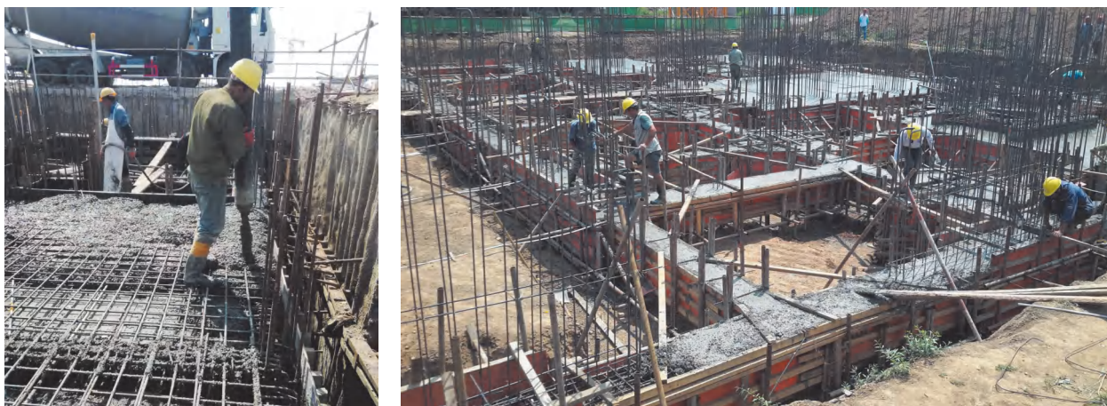
图 1-1-3 钢筋混凝土结构施工现场
