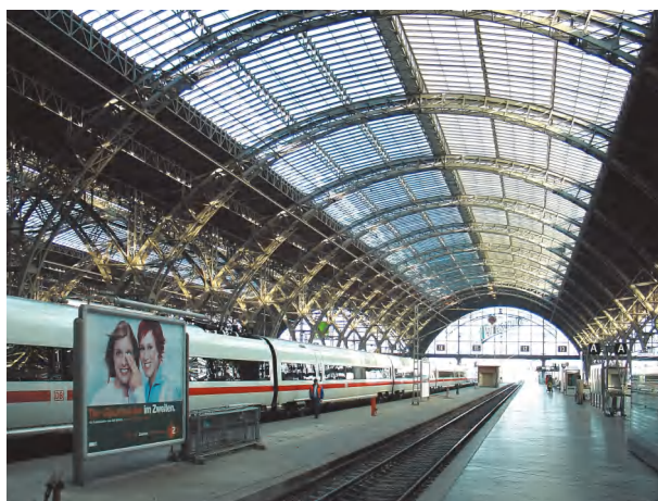
图 1-2-5 欧洲火车站常见的巨大钢结构采光屋顶
