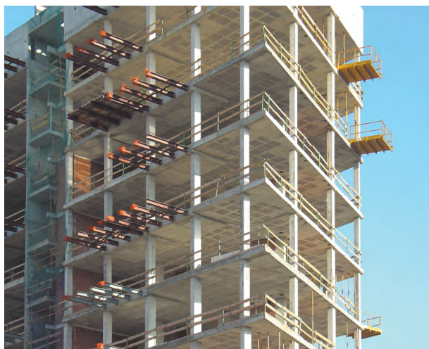
图 1-2-16 钢筋混凝土框架
