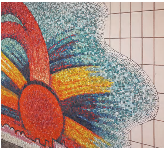
图 1-1-5 陶瓷面砖与马赛克拼贴组合装饰的墙面
