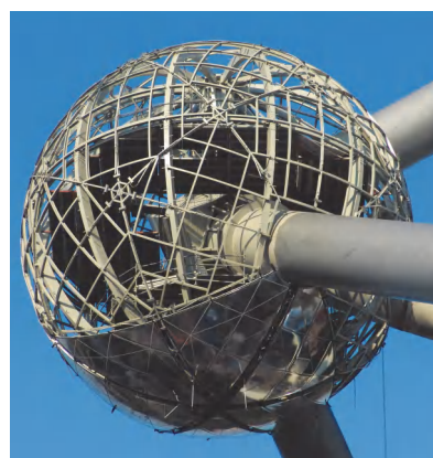
(c) 布鲁塞尔原子塔施工中的钢结构
