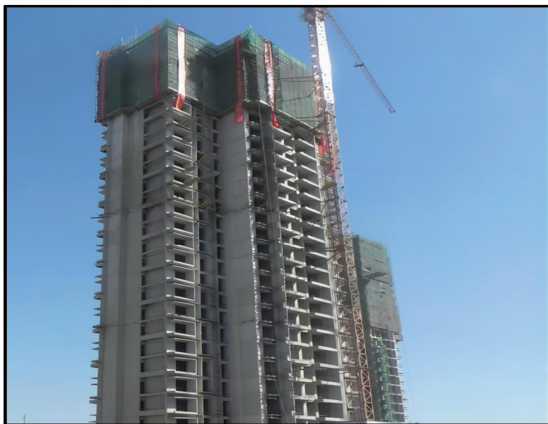
图 1-2-6 框架剪力墙结构
