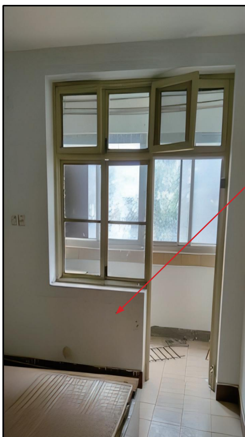
图 1-2-16 阳台边的矮墙不能拆
