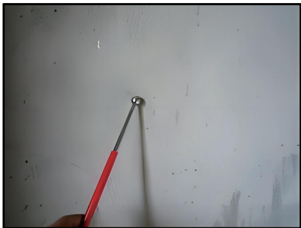
图 1-2-19 敲墙体听声音判断是否为承重墙
