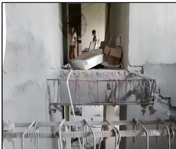
图 1-2-15 墙体、梁、柱、楼板中的钢筋不能拆
