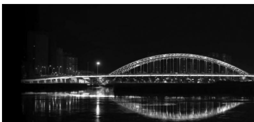
图 1-3 武烈河大桥夜景
