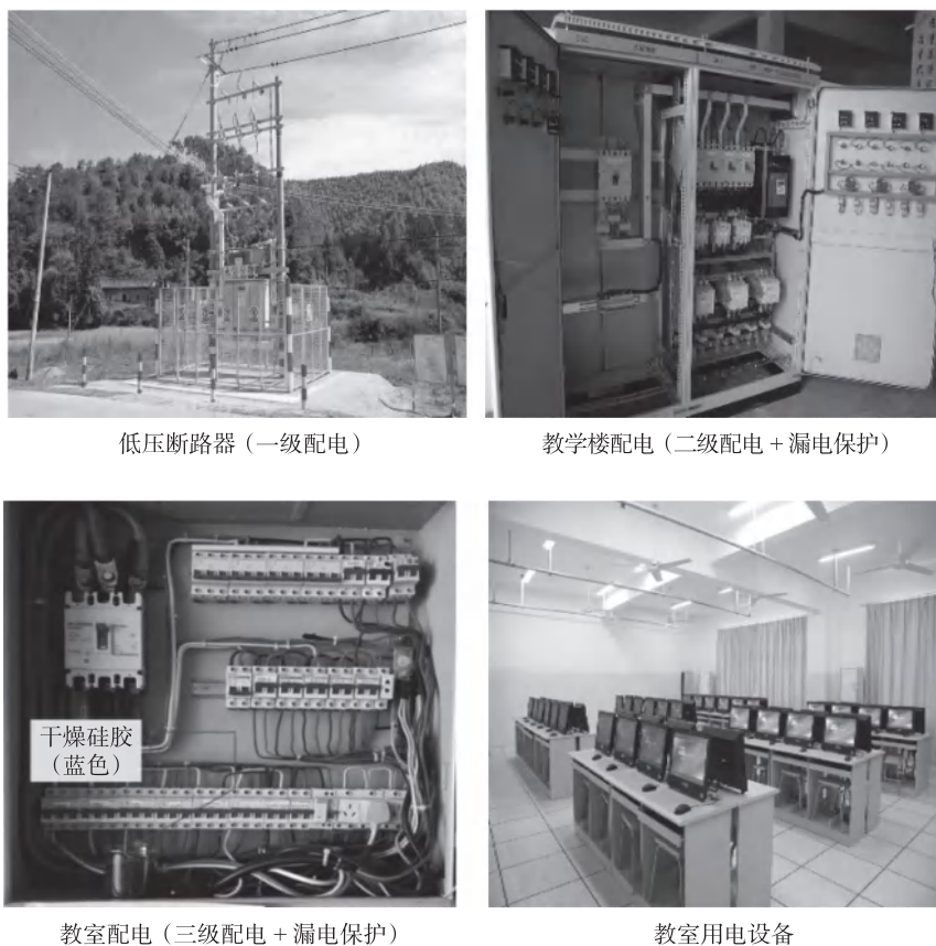
图 2-14 学校三级低压配电系统
