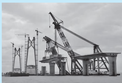
图 1-8 大节段钢箱梁海上吊装架设
