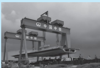
图 1-7 大节段钢箱梁运
