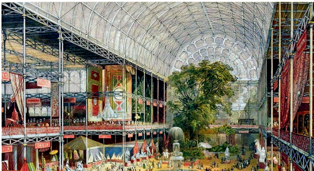
图1-18 “水晶宫”建筑内景，它完全由标准化生产的钢和玻璃组装建成，是建筑史上的一个奇迹
