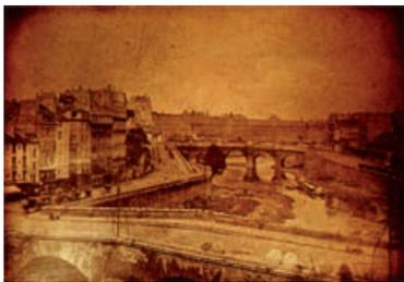
达盖尔拍摄的巴黎塞纳河畔,他用碘蒸气使镀银的铜板表面形成具有感光作用的碘化银,拍摄时曝光15—30分钟,然后将已曝光的经过光敏化处理的镀银铜板放在加热的水银上熏制进行“显影”,显影后的镀银铜板再放入食盐溶液中使未曝光的碘化银失去感光作用进行“定影”。等铜板水洗晾干后,人就能在一定的角度下观看到细腻、锐利的精美影像。
