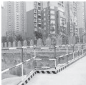
图 1-6 深基坑边防护
