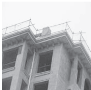
图 1-8 屋面临边防护
