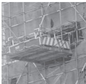
图 1-10 卸料平台边防护
