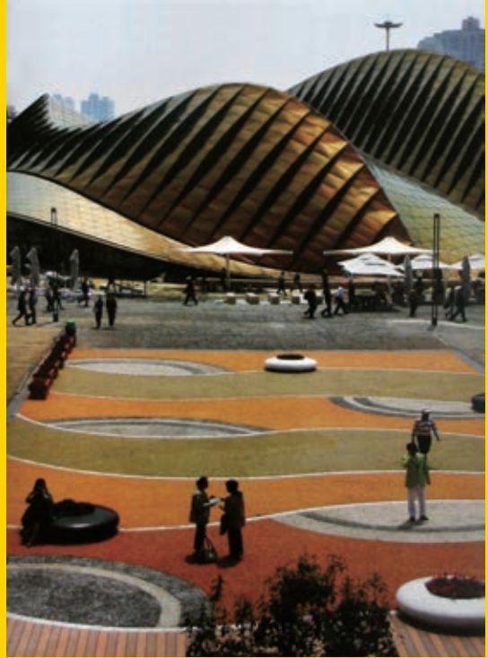
用金钢砂耐磨材料与花岗石构成的层次丰富的彩色地坪
