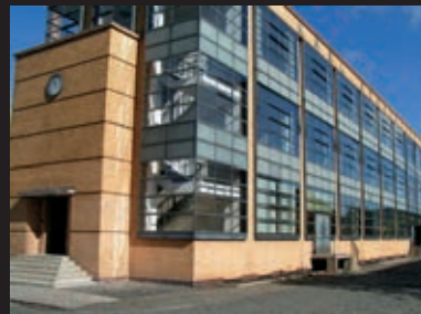
格罗皮乌斯在他设计的包豪斯校舍的实验工厂中充分地运用玻璃幕墙。这座四层厂房，二、三、四层有三面是全玻璃幕墙，成为后来多层和高层建筑采用全玻璃幕墙的先声。
