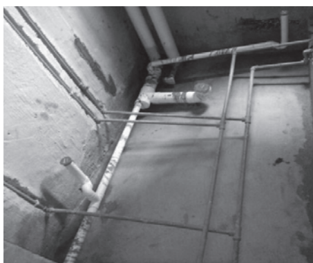
水电材料及施工
