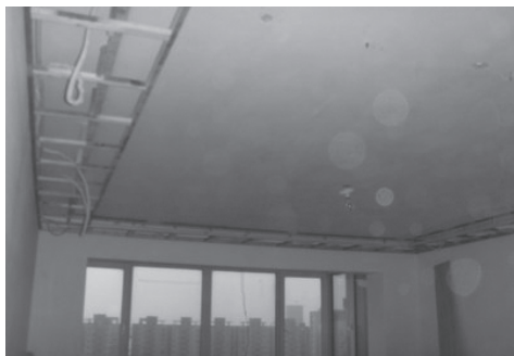
木工材料及施工
