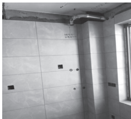
泥工材料及施工
